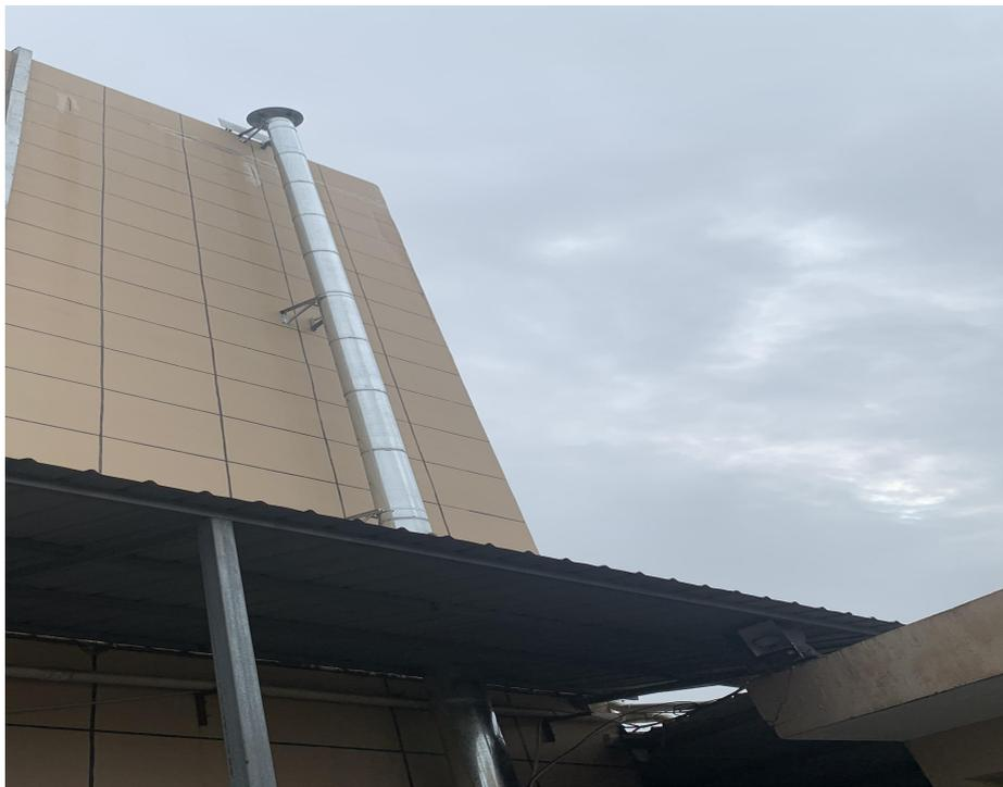
抛光废气水喷淋除尘设施及排气筒
